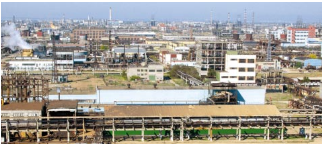
Общий вид площадки в Волгограде
